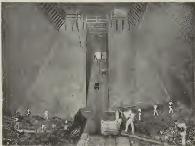
Fig. 2. - Entrada de la mina. Un plano inclinado en una cámara subterránea de las salinas de Slanic
